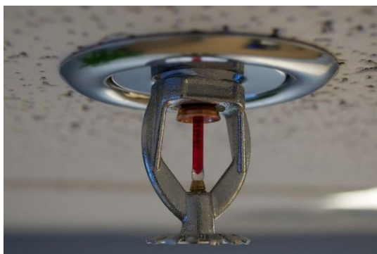
FIGUR 2: ETT SPRINKLERHUVUD MED RÖD GLASAMPULL OCH EN NOMINELL AKTIVERINGSTEMPERATUR PÅ 68 ° C. VID UPPNÅDD TEMPERATUR SPRICKER GLASAMPULLEN OCH VATTNET BÖRJAR FLÖDA MOT SPRIDARPLATTAN I BOTTEN, SOM FÖRDELAR VATTNET ÖVER YTAN SOM SPRINKLERN VERKAR PÅ. ("SPRINKLERHUVUD MONTERAT I TAK". FOTO: BRANDON LEON, CC BY-SA 2.0, VIA WIKIMEDIA COMMONS.)
